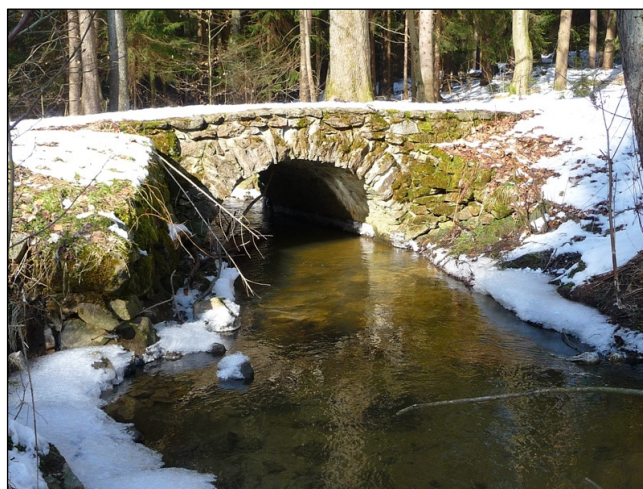
Gewölbter Prießnitzdurchlass im Zuge des Nachtflügels
